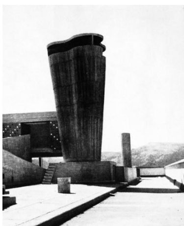
Fig. 78 - Chaminé de ventilação em forma de cone invertido
