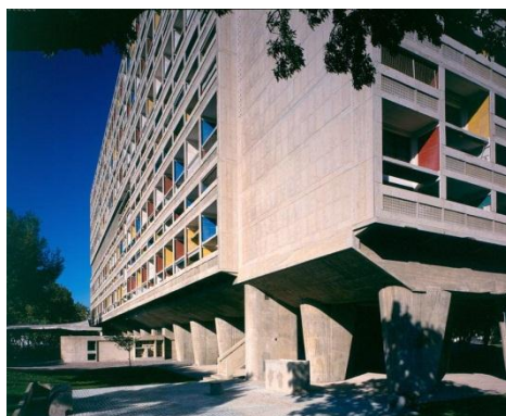
Fig. 62 - Fachada Oeste - Chapéu de entrada
