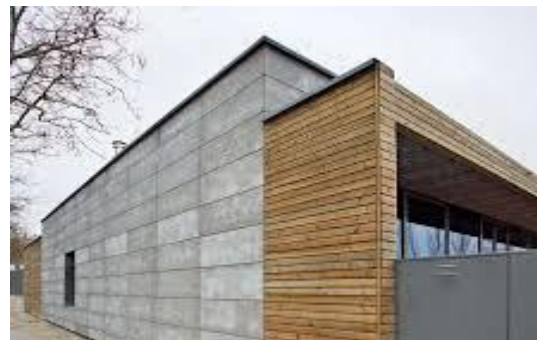
Figura 34: Acabamento exterior com placas VIROC (cinza)
