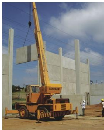
Figura 4: Aplicação de elementos pré-fabricados num edifício
