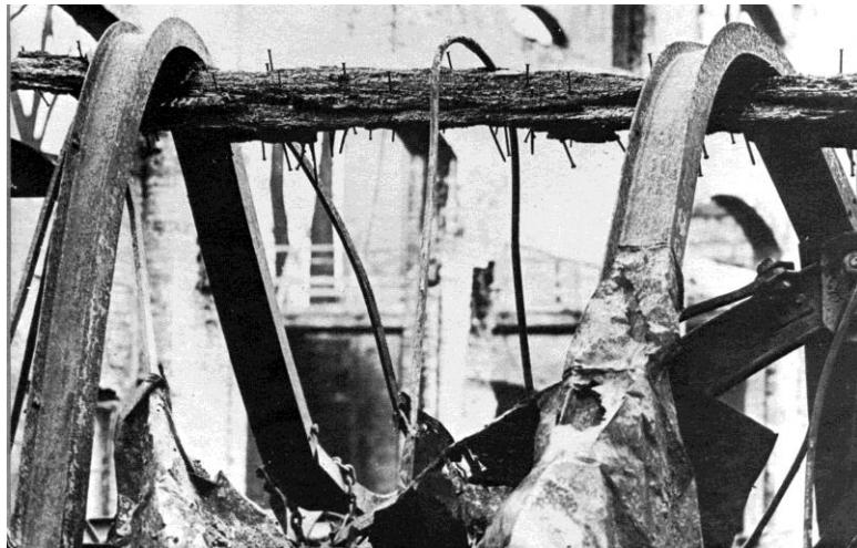
Figura 22: Vigas metálicas derretidas por incêndio enquanto são suportadas por uma viga de madeira que resistiu. (DIAS, 2007)
