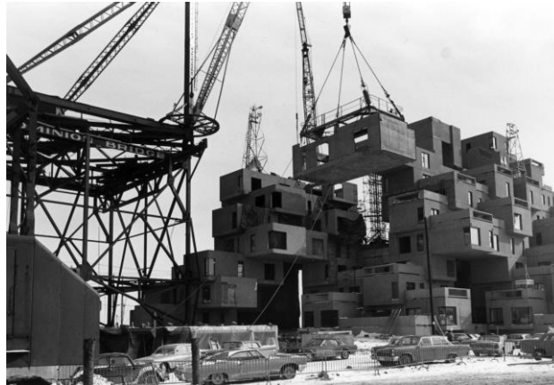
Figura 5: Construção do conjunto habitacional, HABITAT 67, CANADÁ
