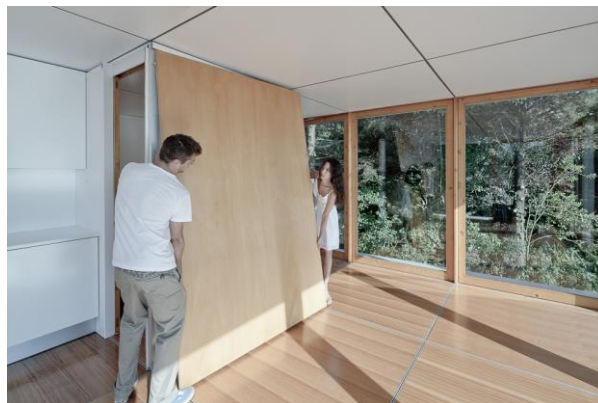
Figura 44: Demonstração de facilidade de trocar os painéis de parede.
