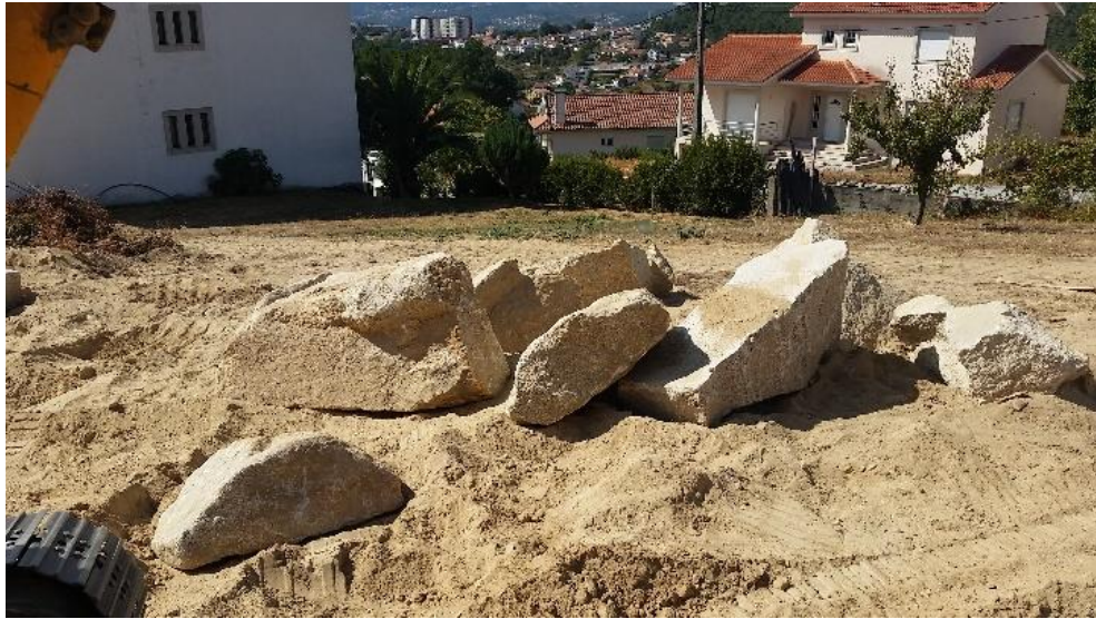
Figura 4 - Pedra irregular usada na construção de um MSAJS
