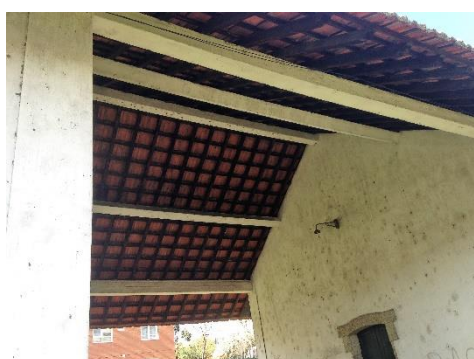
Imagem 91| Estrutura do armazém, fevereiro 2017
