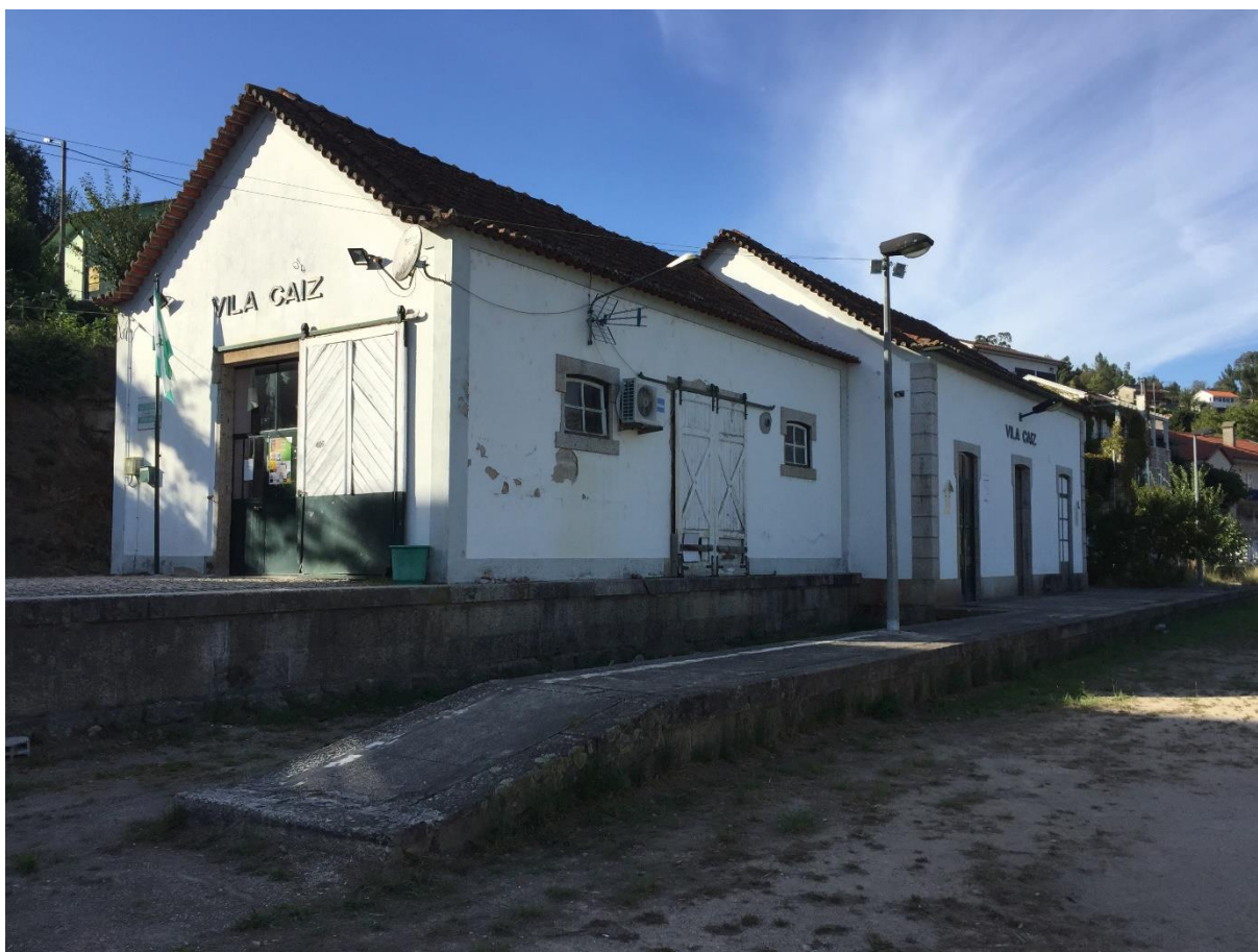
Imagem 43| Estação ferroviária de Vila Caiz, outubro 2017
