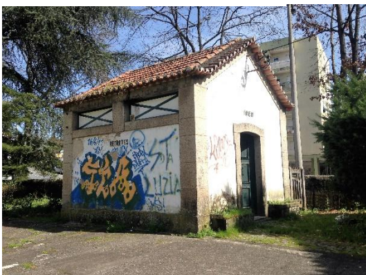
Imagem 81| Instalações sanitárias da Estação ferroviária de Amarante, outubro 2017
