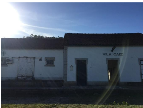
Imagem 23 | Armazém anexo, Estação ferroviária de Vila Caiz
