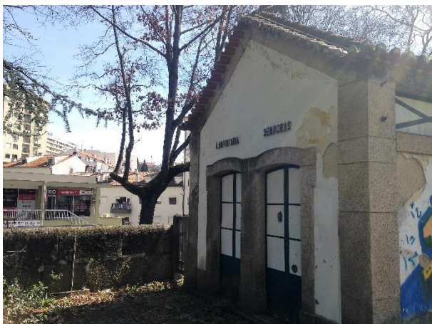
Imagem 67 | Edifício das instalações sanitárias anexas à estação, I.S. senhoras e lampistaria, março 2017
