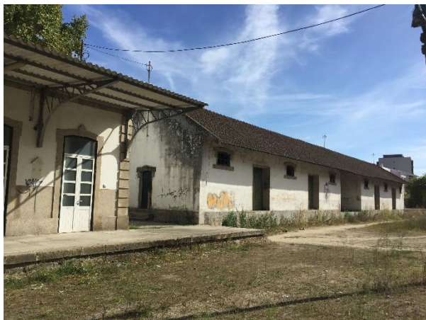
Imagem 71|Alçado posterior do armazém da estação, outubro 2017
