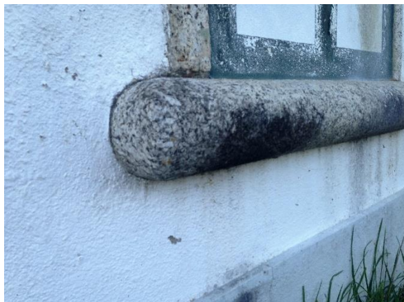
Imagem 38| Peitoril de uma janela da Estação ferroviária de Fregim-A, fevereiro 2017
