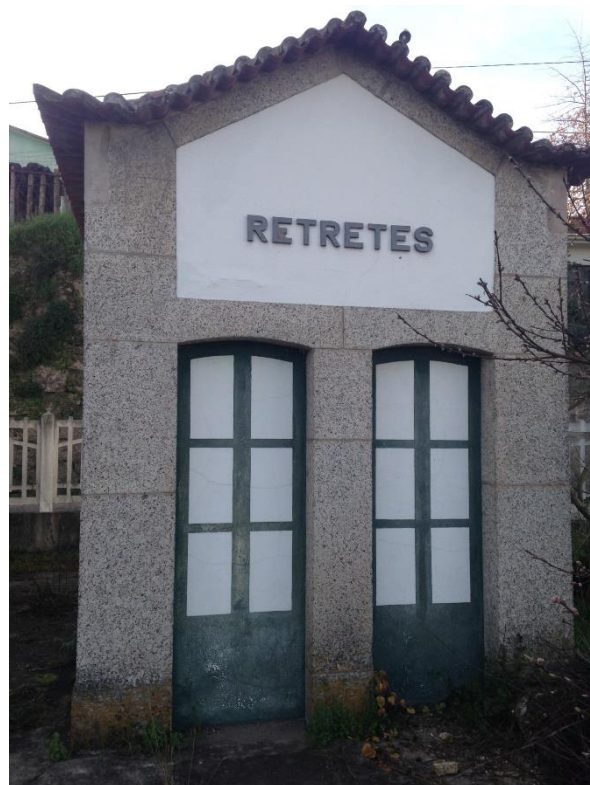
Imagem 48| Instalações sanitárias da Estação de Vila Caiz, outubro 2017
