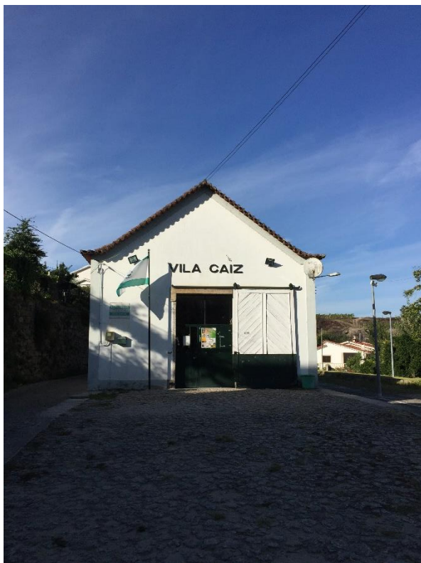
Imagem 47| Alçado lateral esquerdo da Estação ferroviária de Vila Caiz, outubro 2017
