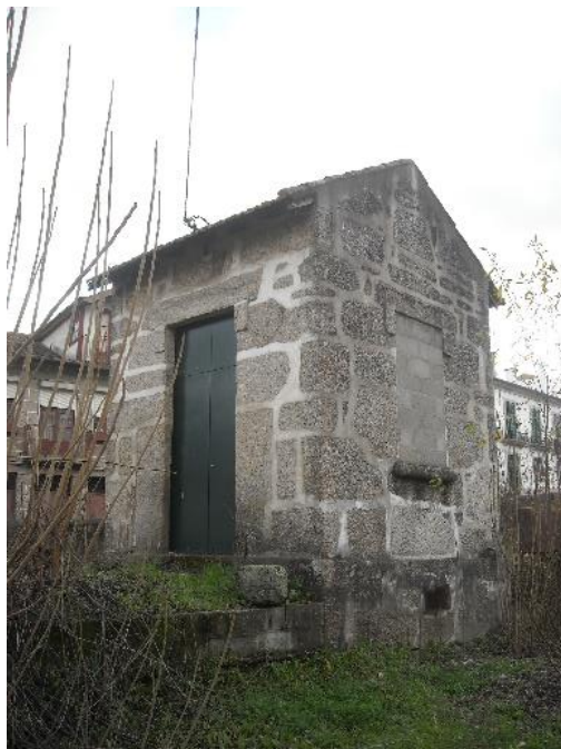
Imagem 74| Entrada para a casa de vigia, fevereiro 2017
