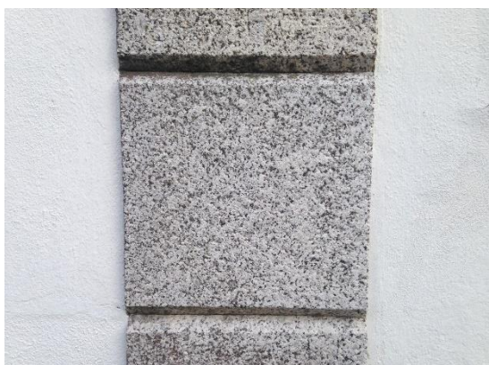
Imagem 53| Detalhe da moldura de granito existente no edifício da estação, fevereiro 2017
