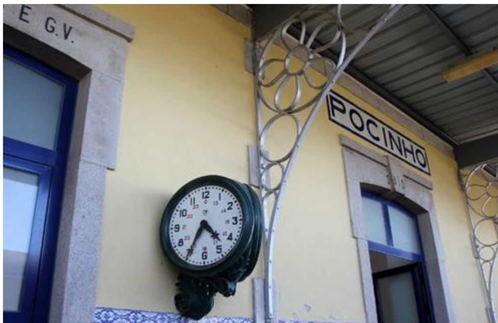
Imagem 26| Alpendre do cais sobre consolas em “margarida” com “argolas” - Estação do Pocinho
