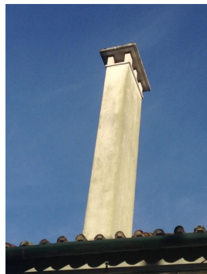
Imagem 57| Chaminé já existente da estação de Vila Caiz, fevereiro 2017
