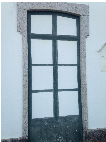
Imagem 55| Porta das instalações sanitárias da estação de Vila Caiz, fevereiro 2017
