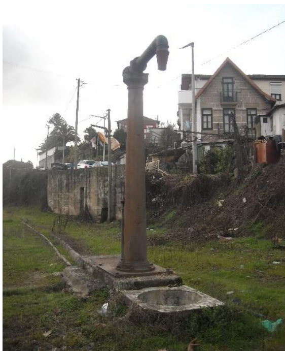
Imagem 20 | Torneira de Água da Estação de Amarante
