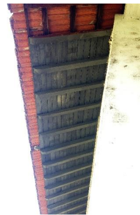
Imagem 93| Estrutura do armazém, fevereiro 2017
