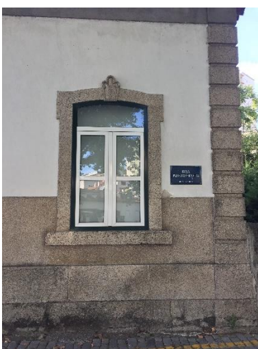
Imagem 83| Janela do alçado frontal da estação ferroviária de Amarante, outubro 2017
