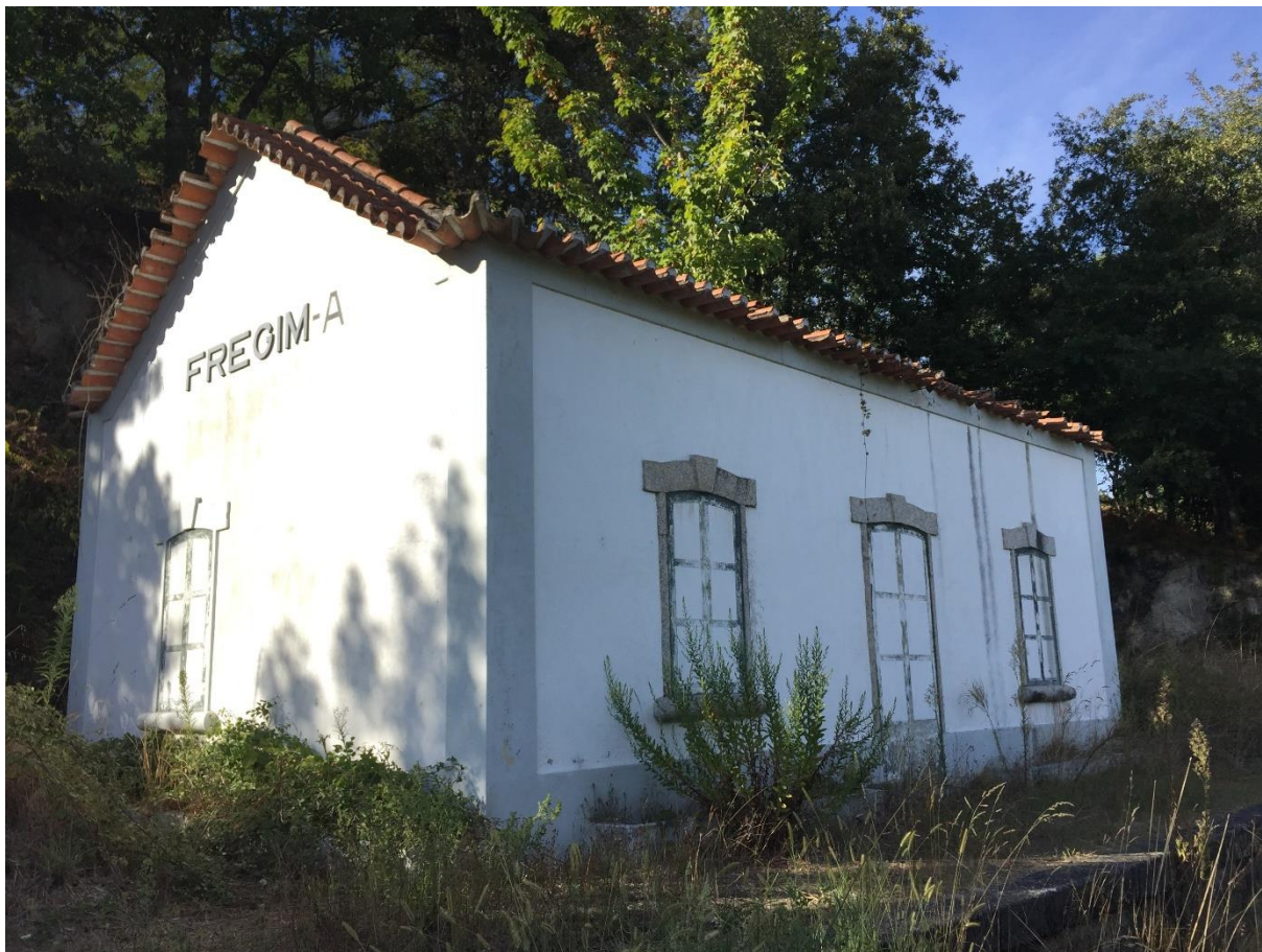
Imagem 32 | Estação ferroviária de Fregim-A
