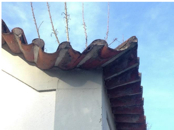
Imagem 37| Beirado da cobertura da Estação ferroviária de Fregim-A, fevereiro 2017
