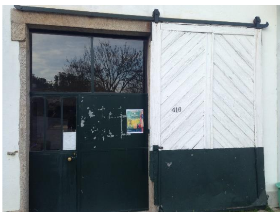
Imagem 58| Porta de entrada mais a sul do edifício, fevereiro 2017
