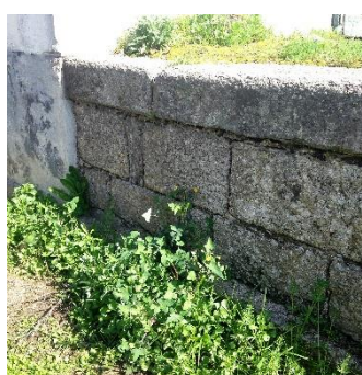
Imagem 89| Muro de granito, fevereiro 2017
