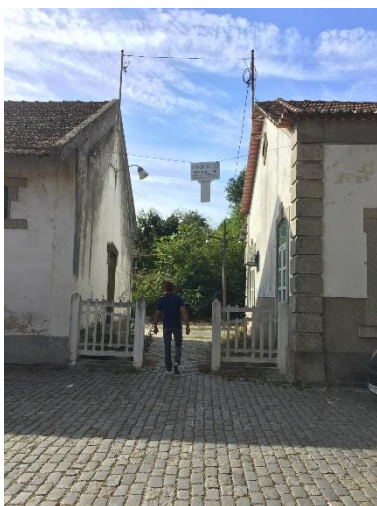
Imagem 69 | Entrada para o espaço ferroviário, outubro 2017
