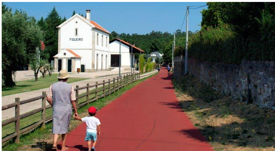
Figura 57 - Estação de Figueiró.
