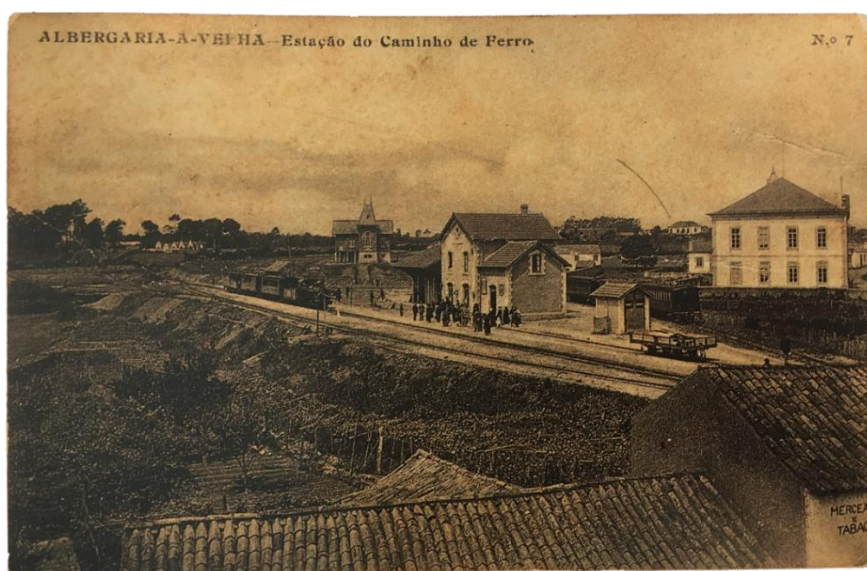
Figura 32 - Postal da estação de Albergaria-a-Velha.
