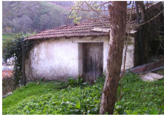
Fig.5.24. Porta de acesso ao piso 1
