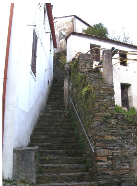
Fig.5.5. Escadaria da Fonte
