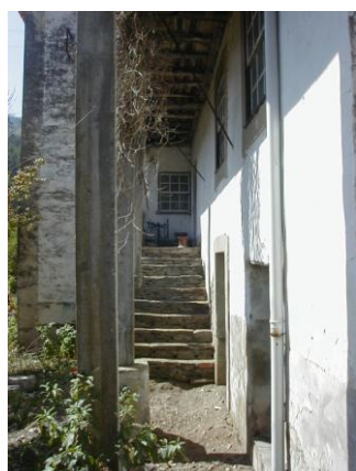
Fig.5.19. Escadas de acesso às lojas e patamares
