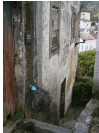
Fig.5.18. Localização da porta que deita para a Escadaria da Fonte
