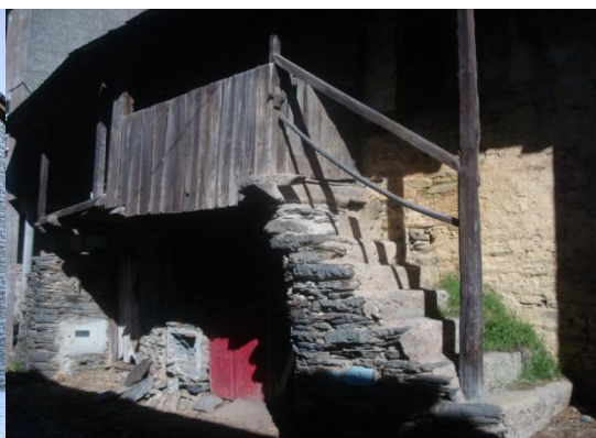
Imagem 23 – Escada e Varanda, por Bruno Alves
