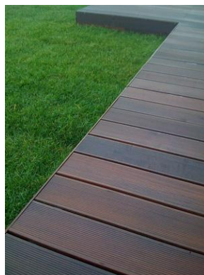
Imagem 34 – Pavimento exterior em Decks de Fenólico
