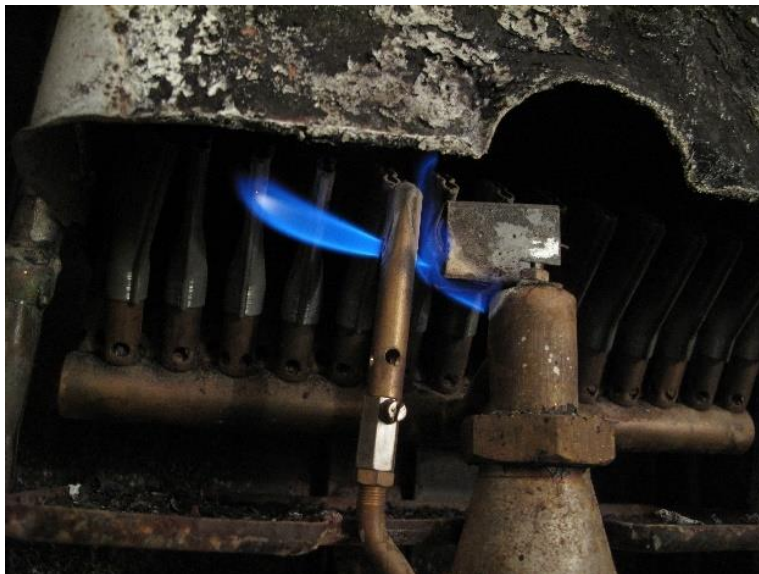
Figura 23 – Sistema de ignição por chama direta. [23]
