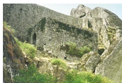
Figura 54 | Porta principal do Castelo de Monsanto, Fonte: António Lopes Pires, Cadernos de património cultural da beira baixa: O castelo de Monsanto da Beira - Cesto de gávea em nave de pedra, Associação da Defesa do Património Cultural e Natural de Penha Garcia, 2003
