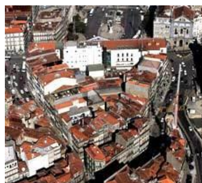
Figura 27 | Quarteirão das Cardosas, Porto, Fonte: http://aeiou.expresso.pt/users/0/14/7586314c.jpg , consultado em 5 de agosto de 2011
