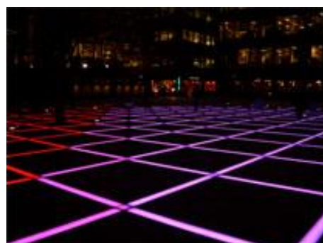
Figura 102 | Instalação com luzes LED,
